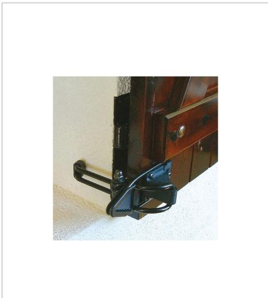
Mécanisme permettant de bloquer un volet en position ouverte.
